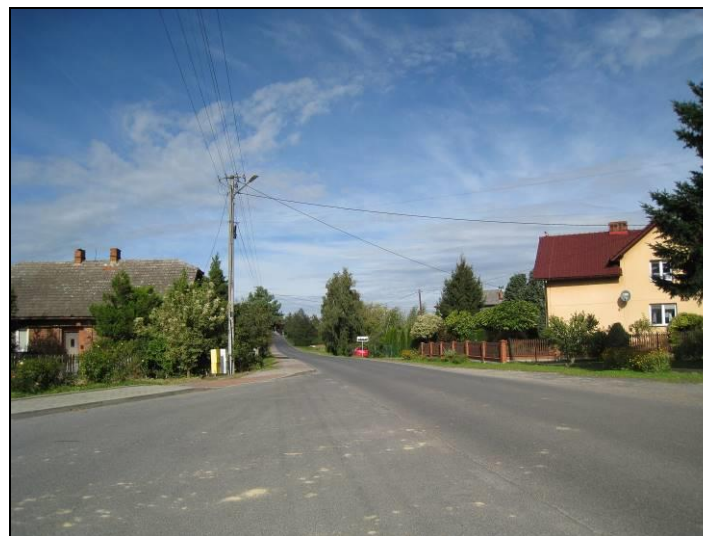
Fot. 3 ul. Andrychowska w południowej części sołectwa
