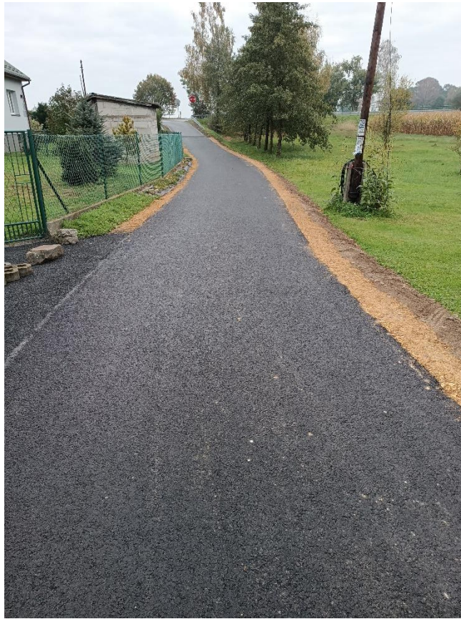
Remont ul. Malwy w m. Las, gm. Przeciszów
