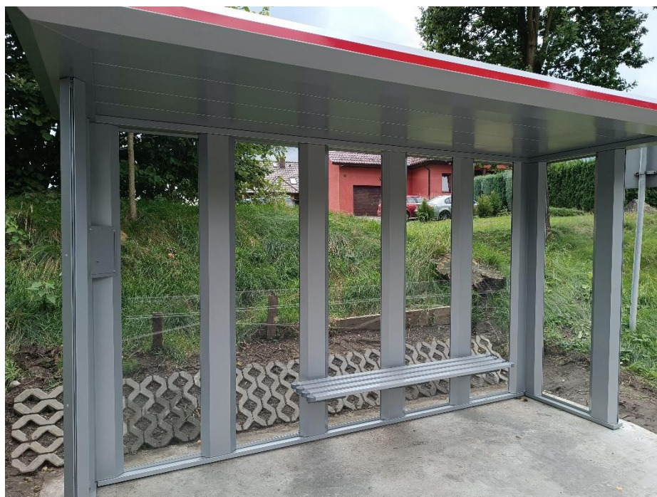
Dostawa wiat przystankowych wraz z ich montażem na terenie Gminy Preciszów
