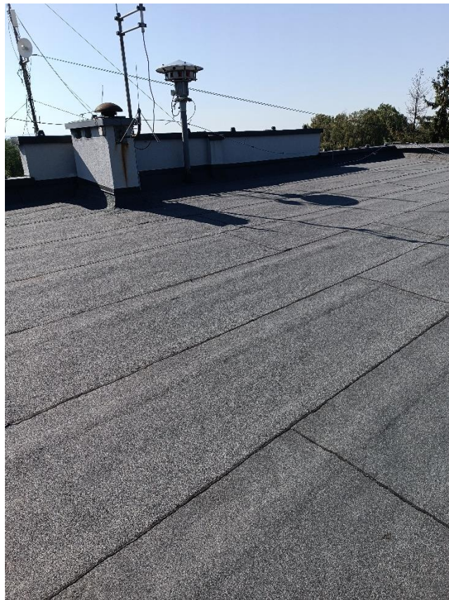
Remont dachu budynku OSP w Piotrowicach przy ul. Andrychowskiej
